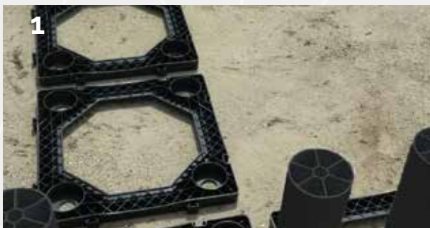
1 Plaatsing van de bodemframes rondom de boomspiegel
