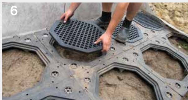
6 Afsluiten van het systeem met deksel
