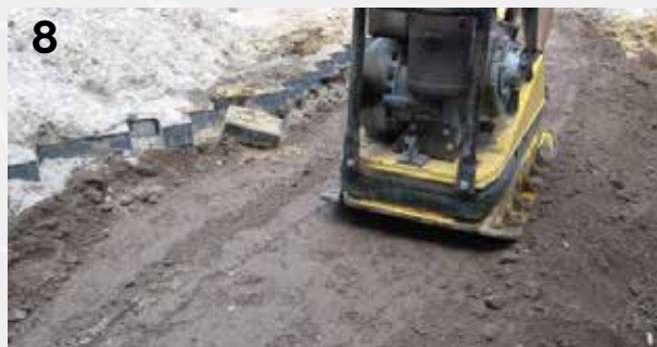
Verdichten und Einbau der gewünschten Pflasterung rund um den Pflanzbereich
