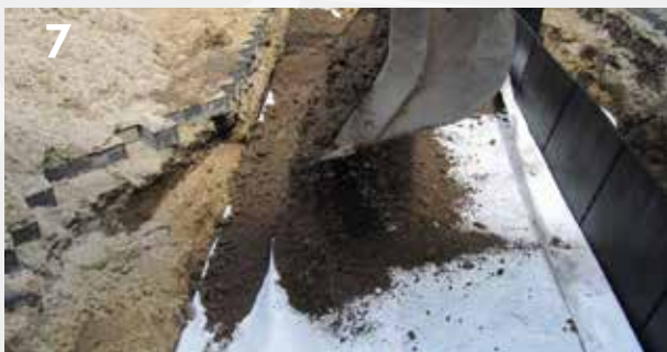
Geotextil verlegen und mit Mischgranulat auffüllen
