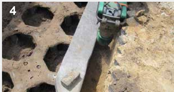
Verfüllen und Verdichten des Bereichs rund um die Baumstandort-Konstruktion
