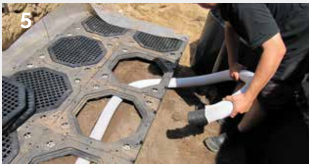
Installation des Belüftungs- und Bewässerungssystems
