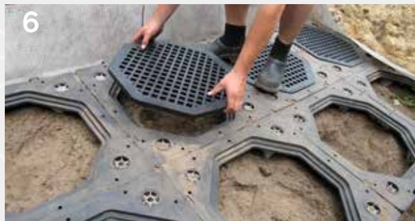
Verschließen des Systems mit Deckel
