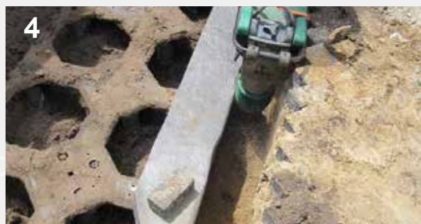
4 Aanvullen en verdichten van de ruimte rondom de groeiplaatsconstructie
