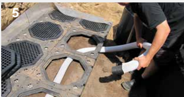
5 Installeren beluchtungs- en bewateringssysteem
