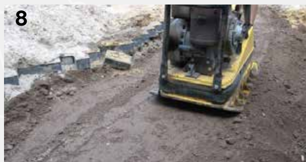
8 Verdichten en aanbrengen van gewenste bestrating rondom het plantvak
