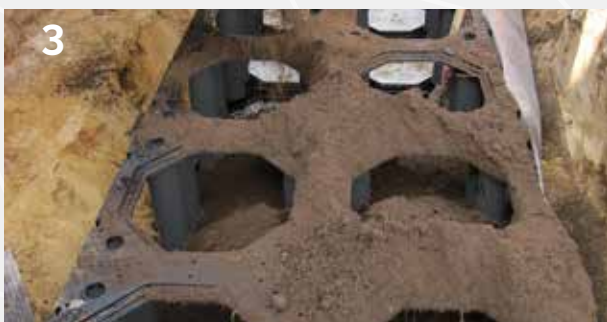
3 Het systeem wordt gevuld met substraat volgens voorgeschreven samenstelling
