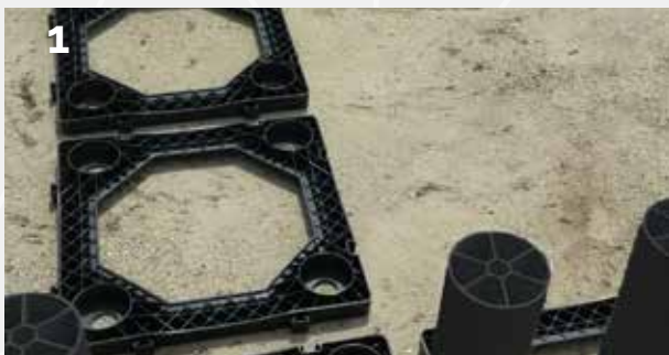
1 Plaatsing van de bodemframes rondom de boomspiegel
