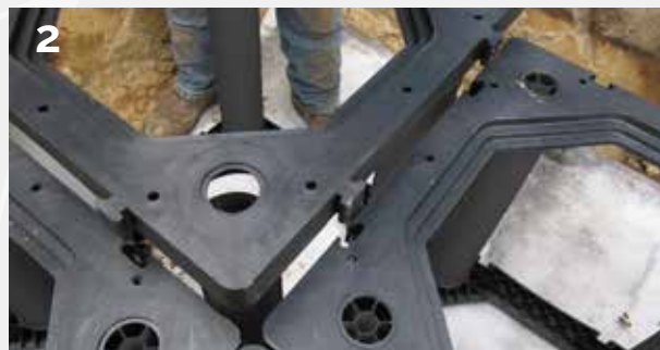
2 Plaatsing van de verticale staanders en bovenframes.
