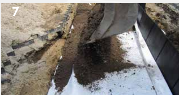
7 Geotextiel aanbrengen en aanvullen met menggranulaat
