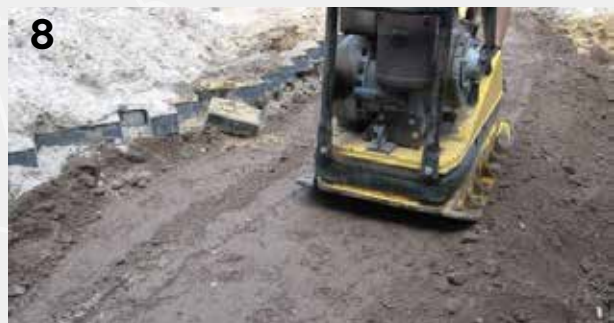
8 Verdichten und Einbau der gewünschten Pflasterung rund um den Pflanzbereich
