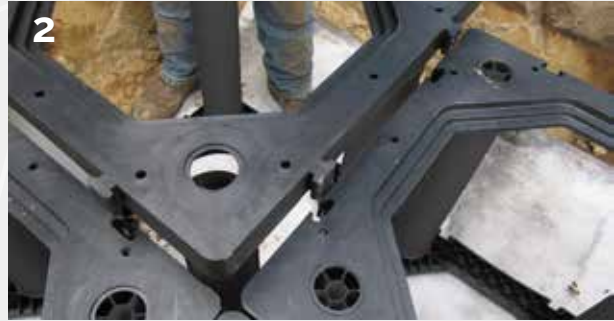
2 Einbau der vertikalen Stützen und Oberrahmen
