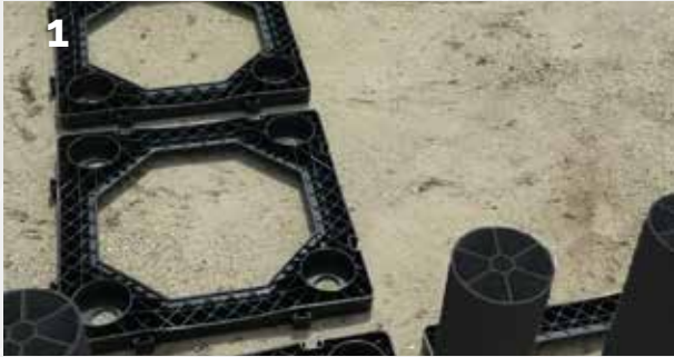
1 Einbau der Bodenrahmen rund um die Baumscheibe
