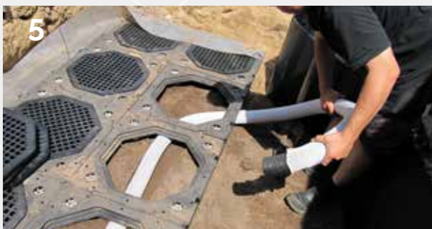
5 Installeren beluchtungs- en bewateringssysteem
