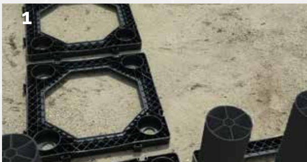
1 Plaatsing van de bodemframes rondom de boomspiegel
