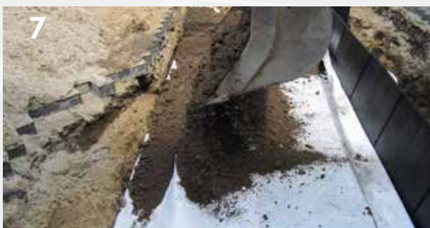
7 Geotextiel aanbrengen en aanvullen met menggranulaat
