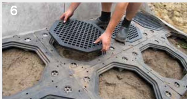
6 Afsluiten van het systeem met deksel
