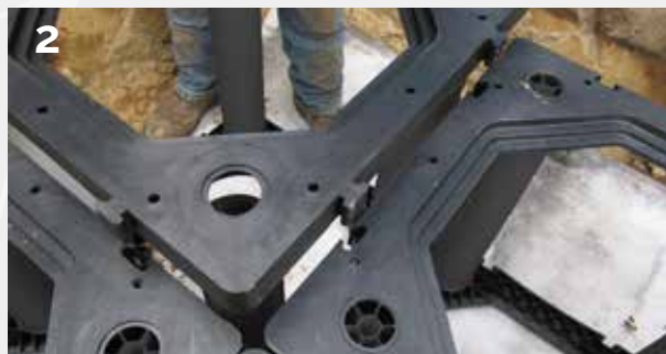
2 Plaatsing van de verticale staanders en bovenframes.
