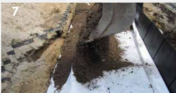
7 Geotextiel aanbrengen en aanvullen met menggranulaat
