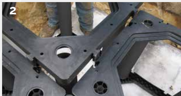
2 Plaatsing van de verticale staanders en bovenframes.
