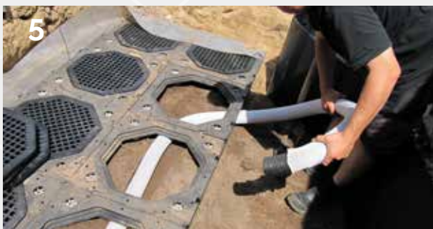
5 Installeren beluchtungs- en bewateringssysteem
