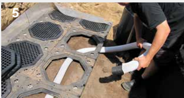
Installeren beluchtungs- en bewateringssysteem
