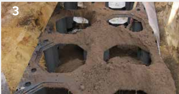
Systeem vullen met bioretentiegrond/ boombunkergrond
