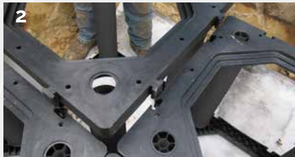
Plaatsen van de staanders en bovenframe
