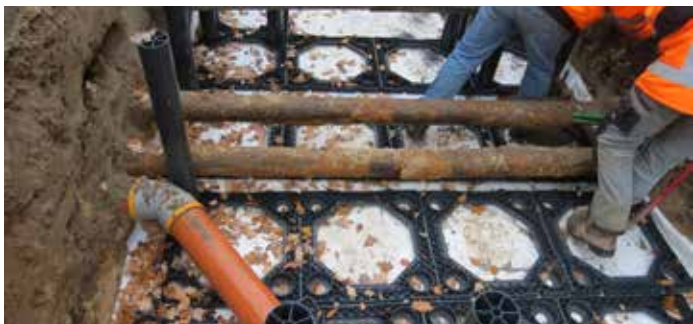
TreeParker® is eenvoudig te installeren, ook rondom kabels en leidingen. Zie voor meer info handboek 'kabels & leidingen Treeparker in de stad'
