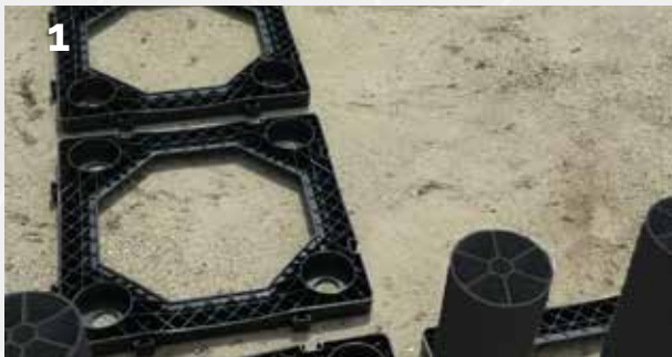
Plaatsen van bodemframes rondom boomspiegel
