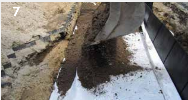
Geotextiel aanbrengen en aanvullen met menggranulaat
