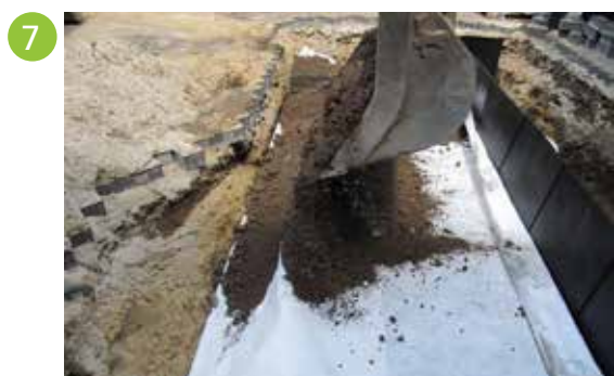
Geotextiel aanbrengen en aanvullen met menggranulaat
