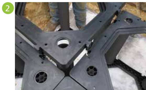
Plaatsen van de staanders en bovenframe
