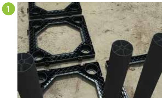
Plaatsen van bodemframes rondom boomspiegel
