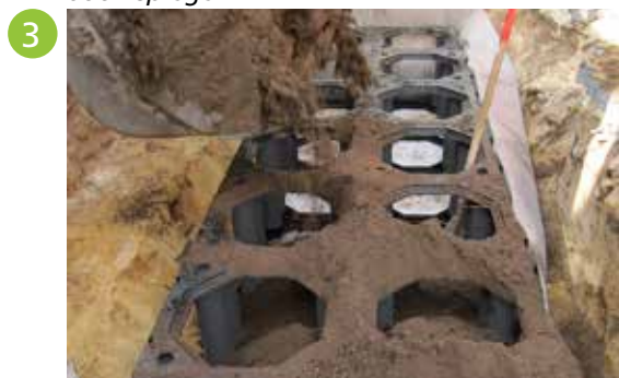
Systeem vullen met bioretentiegrond/ boombunkergrond
