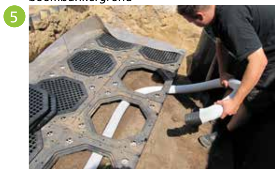
Installeren beluchtungs- en bewateringssysteem
