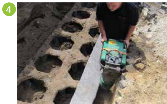
Aanvullen/verdichten rondom systeem
