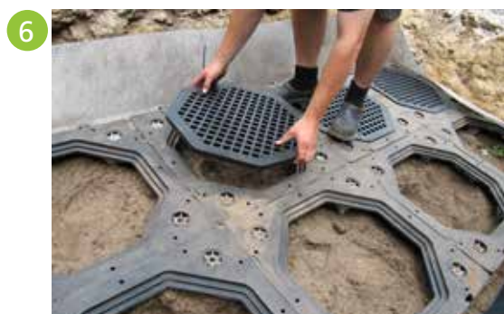
Afsluiten van het systeem met deksel
