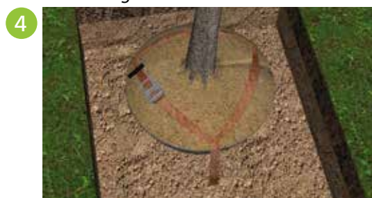
Span de gordels goed vast, herhaal dit na twee dagen, verwijder daarna de aanspanhendel
