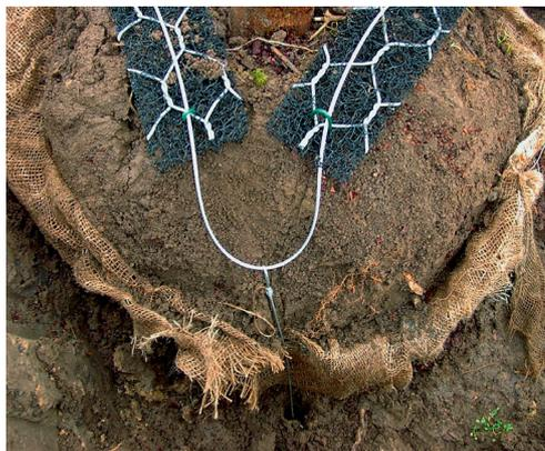
**Abbildung 2: Einbau der Variante RF1 mit PLATI-MAT PM1**
